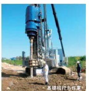
基礎杭打ち作業
